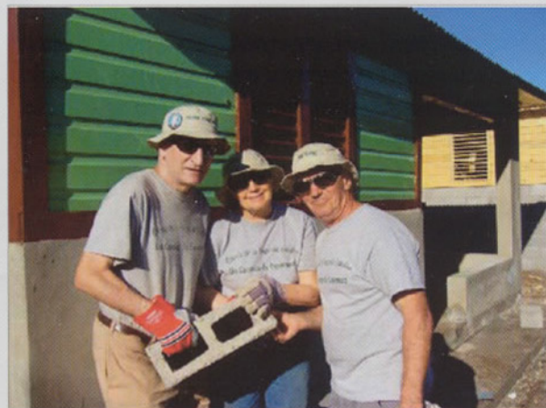
Maison que nous avons construite en République Dominicaine.
